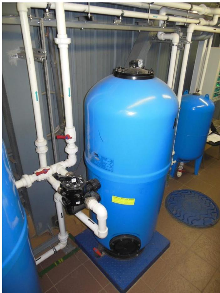
**Фильтр тонкой очистки (ФТО)** - предназначен для фильтрации суспензий с максимальной концентрацией взвешенных веществ – 20 мг/л. Изготавливается из полиэфир армированного стекловолокном. В качестве фильтрующей загрузки используются гранулы сорбента. Фильтр обладает высокой механической, химической и термической стойкостью.
